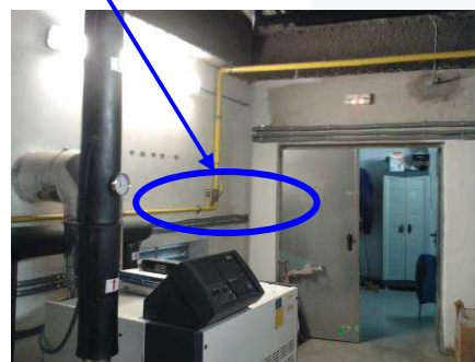
Sala de Calderas (5ª Planta)
